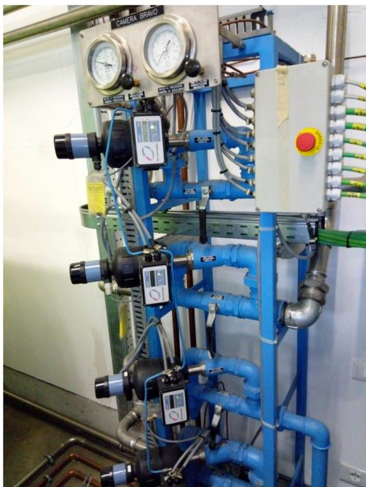
*Figure 33. Postazione di comando manuale di compressione e decompressione - by Andrea Congiu*
